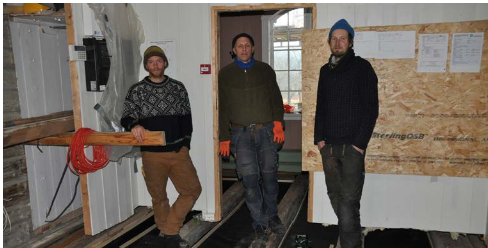
Det er et internasjonalt arbeidslag som jobber i Sauherad kirke. Fra Venstre: Johan Friisoe (fra USA), Jørn Berget fra Bø og Svein Knarud fra Hadeland.
