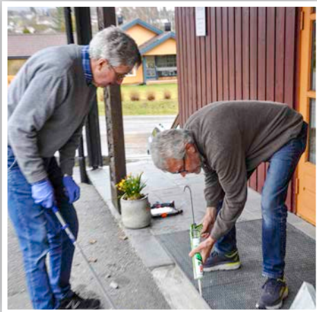
Mandag 24. april var det vårdugnad på Nes menighetshus. Det ble vasket og ryddet, tørket støv og pusset vinduer. Og gjort noen reparasjoner. Arne Aune (t.v.) og Johannes Sand fikset ei løs helle ved inngangsdøra. Foto: Ivar Solbu
