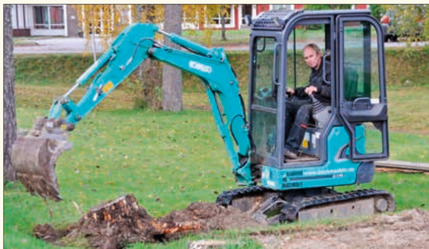
Fjerning av røtter
