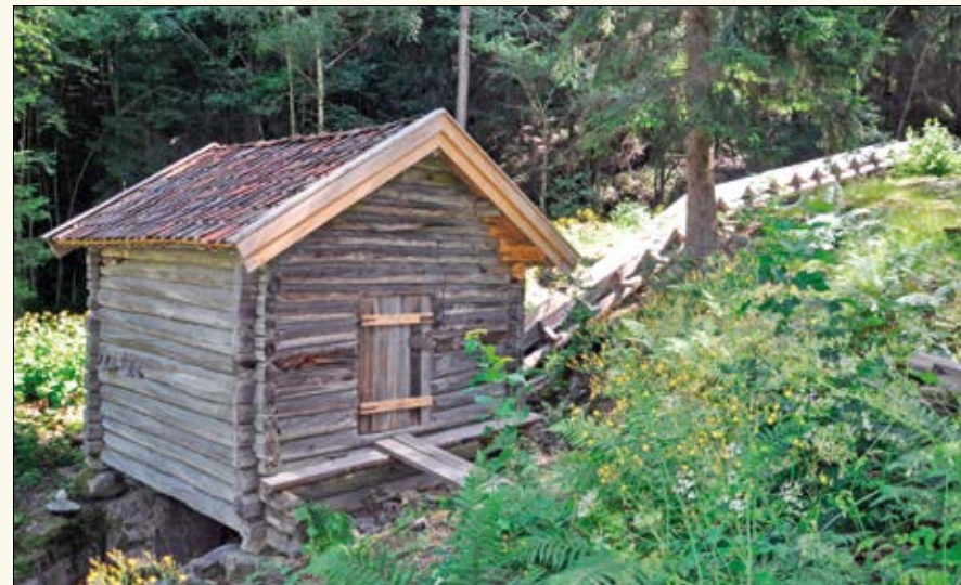
Holtakverna ble satt opp rund år 1800. Vassrenna er bygd ny, men på kvernhuset er det bare gjort mindre utbedringer.
