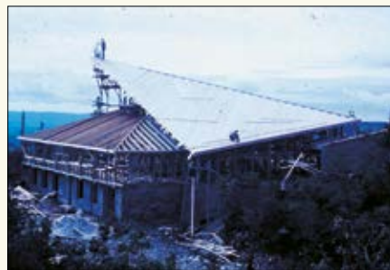
Taket er på plass. En luftig arbeidsplass med god utsikt.
